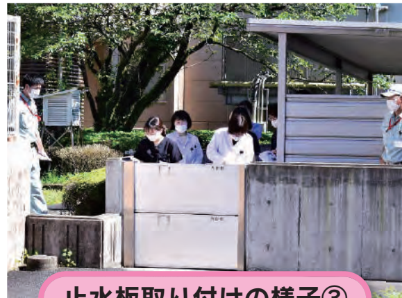
止水板取り付けの様子③
