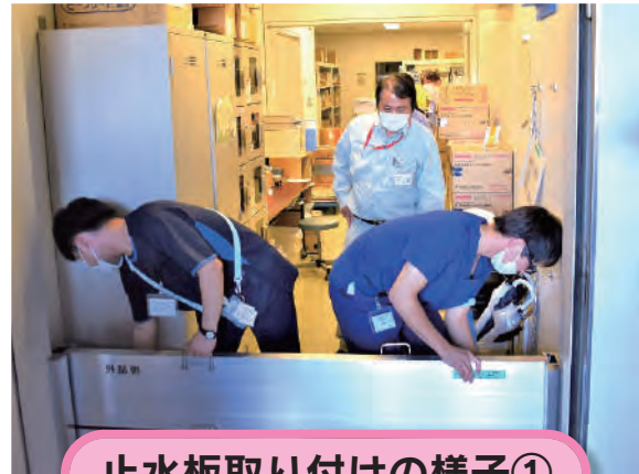
止水板取り付けの様子①
