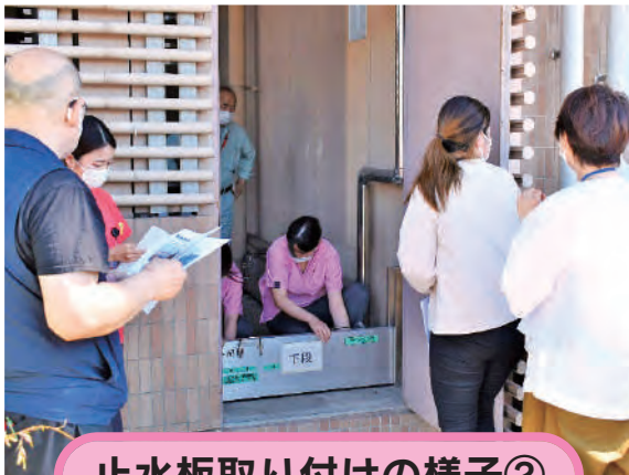
止水板取り付けの様子②
