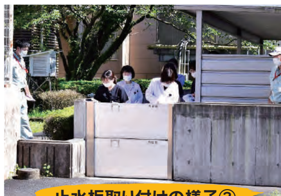
止水板取り付けの様子③
