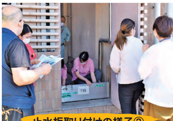
止水板取り付けの様子②
