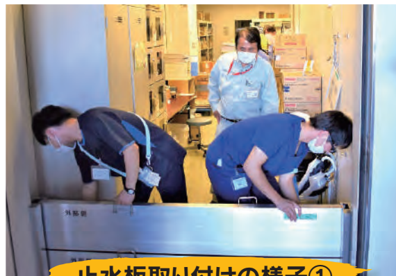
止水板取り付けの様子①
